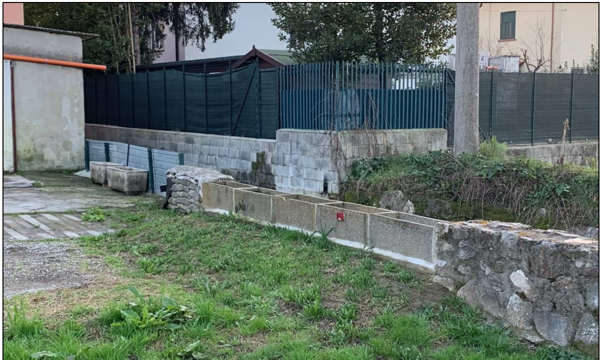
Figura 4.4 - «Opere di sponda» provvisorie poste nel tratto non sistemato del corso d'acqua.
